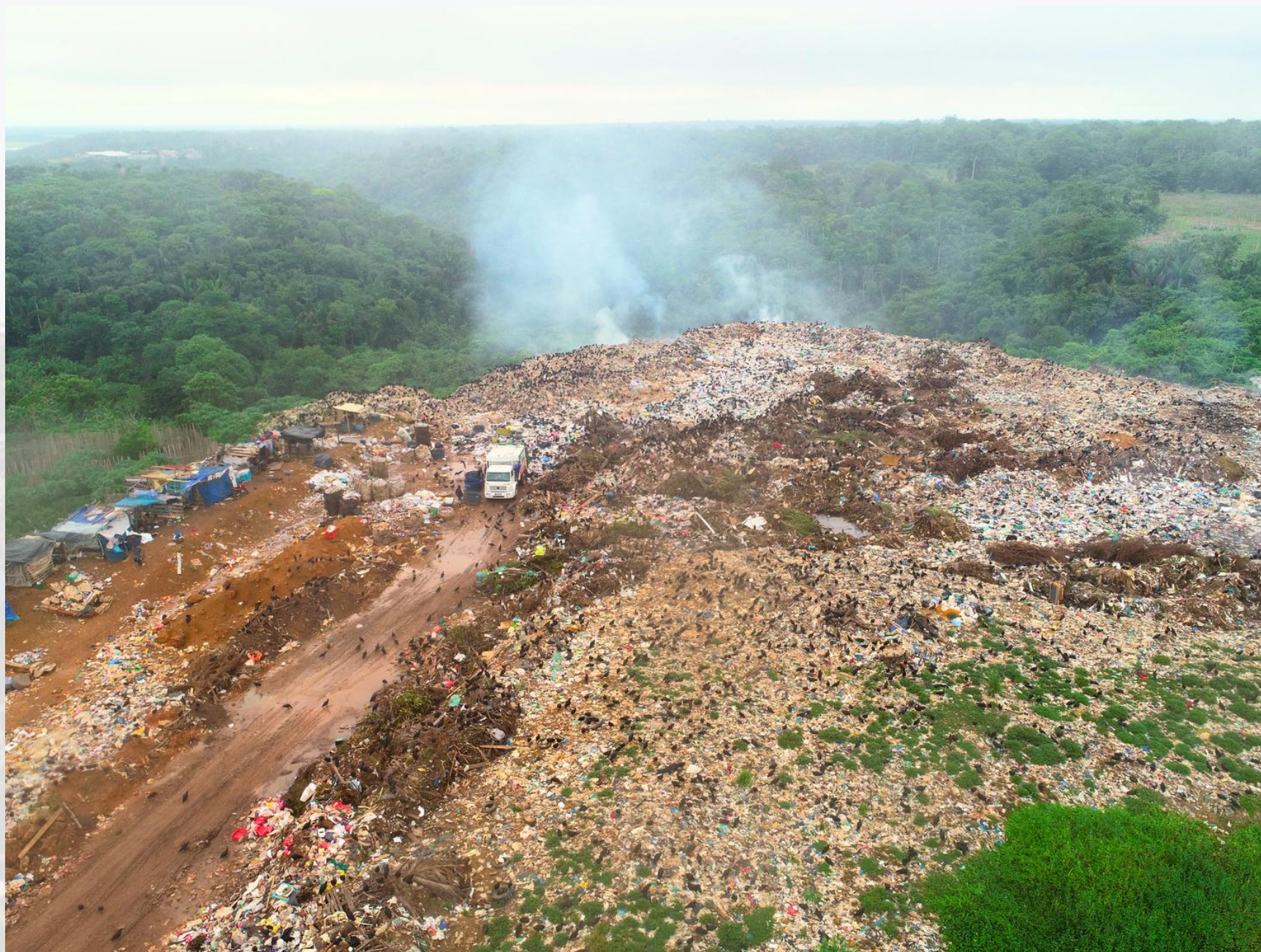
FUMAÇA GERADA PELA QUEIMA DOS RESÍDUOS FORTE PRESENÇA DE CATADORES
