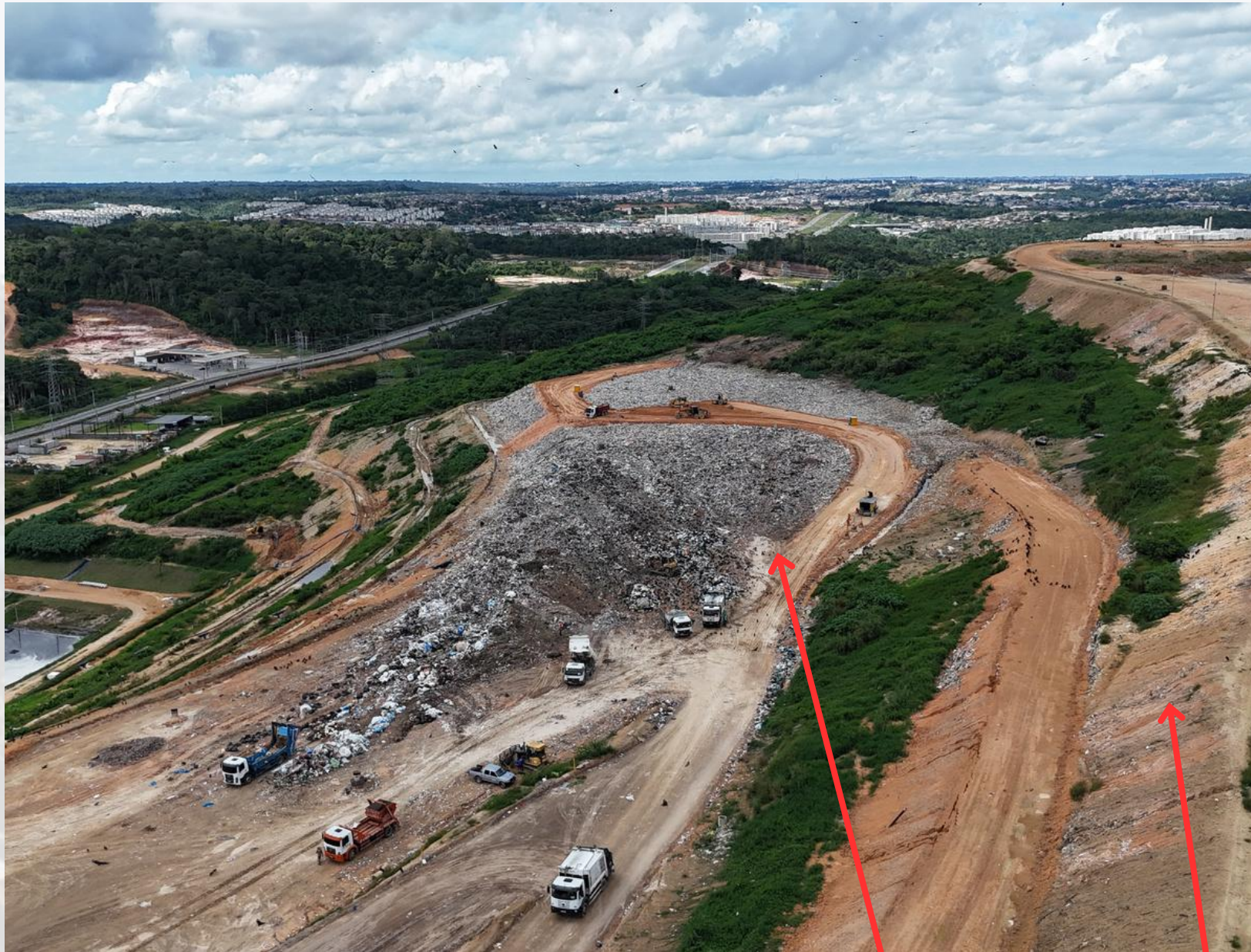
RESÍDUOS SEM RECOBRIMENTO DIÁRIO ATRAINDO AVES
