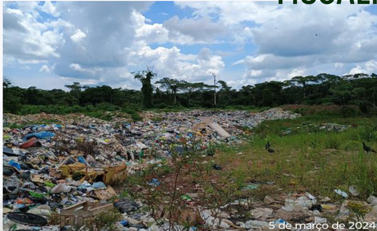
Rampa de acesso às áreas de disposição de resíduos sólidos, totalmente tomadas por pilhas de lixo. Vazadouro em total descontrolo .
