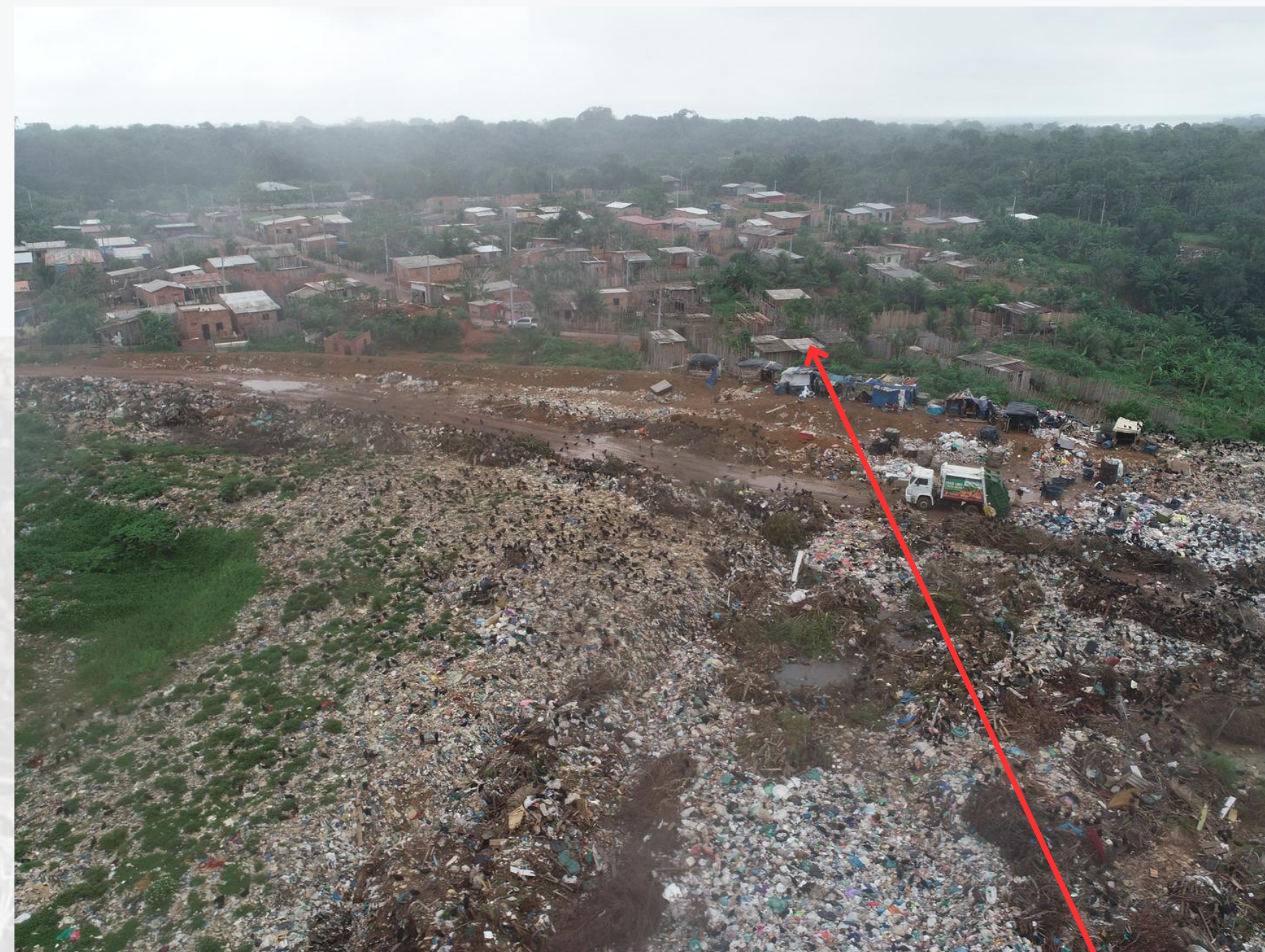
COMUNIDADE CASTANHEIRAS COMUNIDADE JÁ PAVIMENTADA ESTABELECIDA EM CIMA DO VAZADOURO
